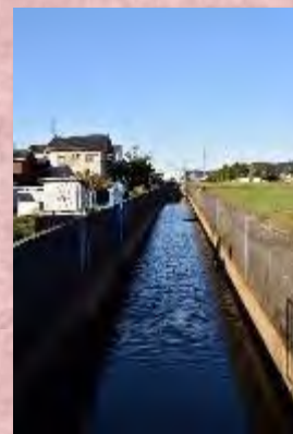
「昭和江」本所保育園付近の水路です。
