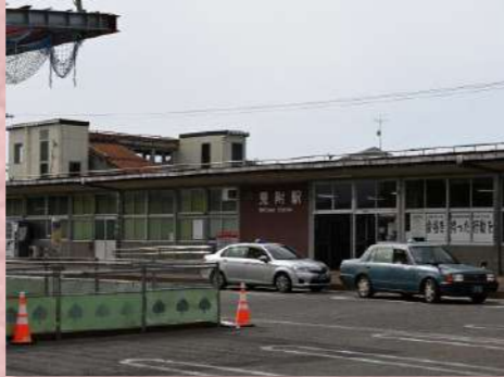
駅前駐車場で進む工事。
